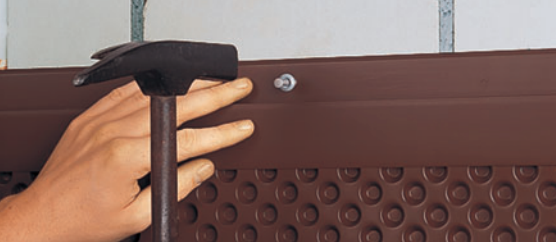
DELTA®-NOPPENBAHNEN-PROFIL fixação do topo.
