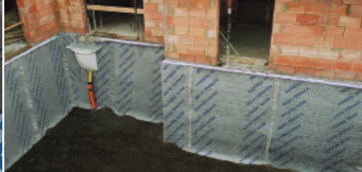
DELTA®-TERRAXX oferece uma drenagem com permanente filtração.
